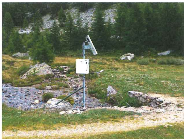
Figura 1.1: Esempio di stazione idrometrica installata su torrente
